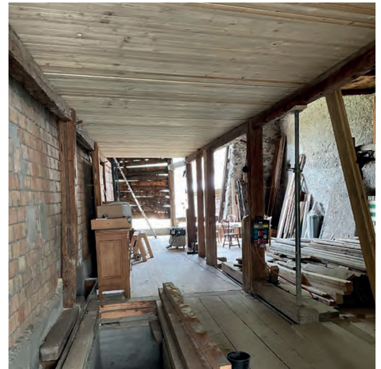
Sascha und Edgar montieren die Deckenelemente 20.04 - 28.04.2023
