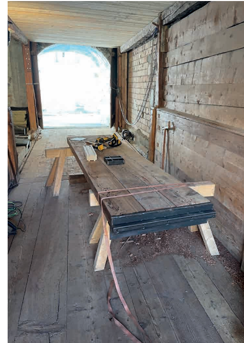
Bodenklappe in Arbeit
