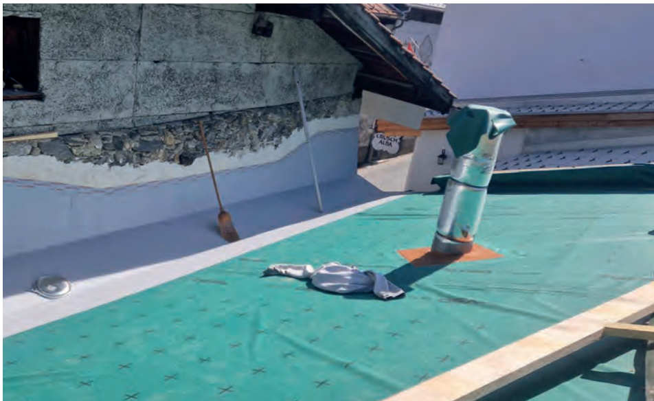
Anschluss Kehle Unterdachfolie 08.04.24
