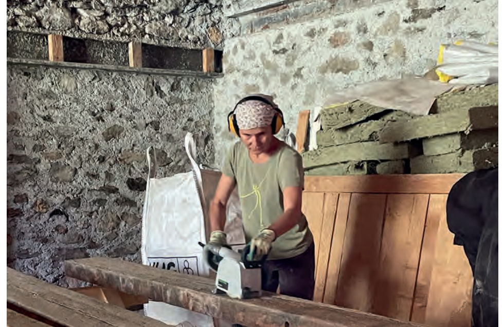
Die Balkenbürstmaschine im Einsatz
