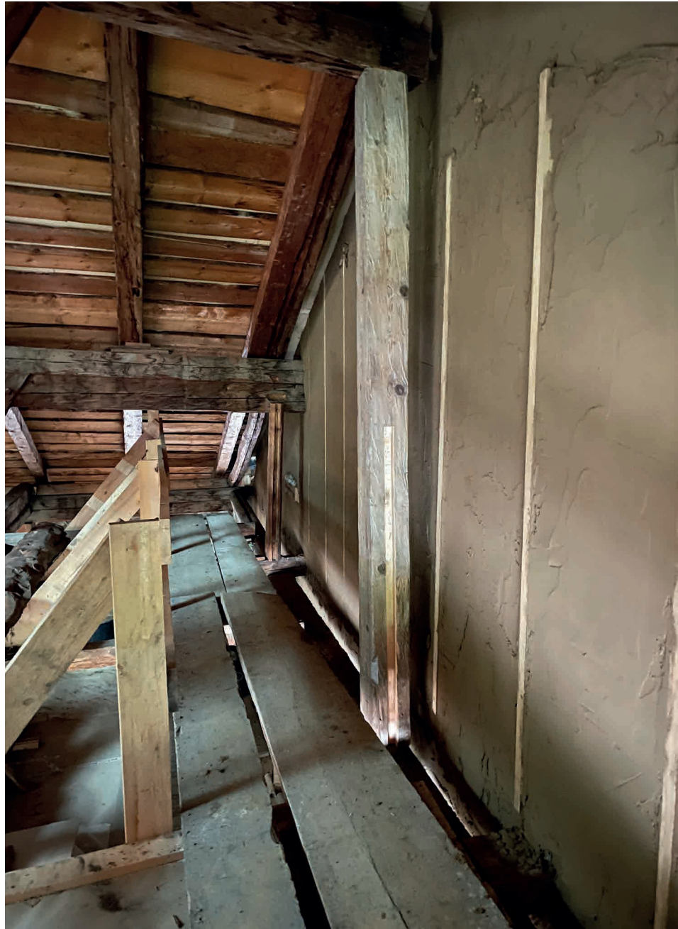
Oben angekommen, ca. 4 to Lehmunterputz 2-4 cm stark
