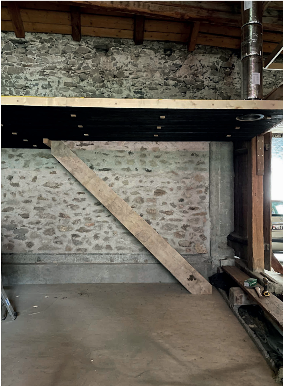
Neue Küchendecke gebrandt mit Treppe 18.03.24
