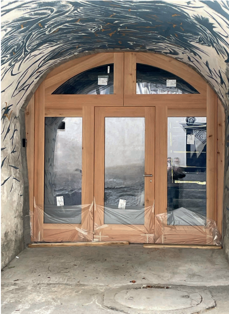
Verglast, Schwelle in Arbeit 27.10.24
