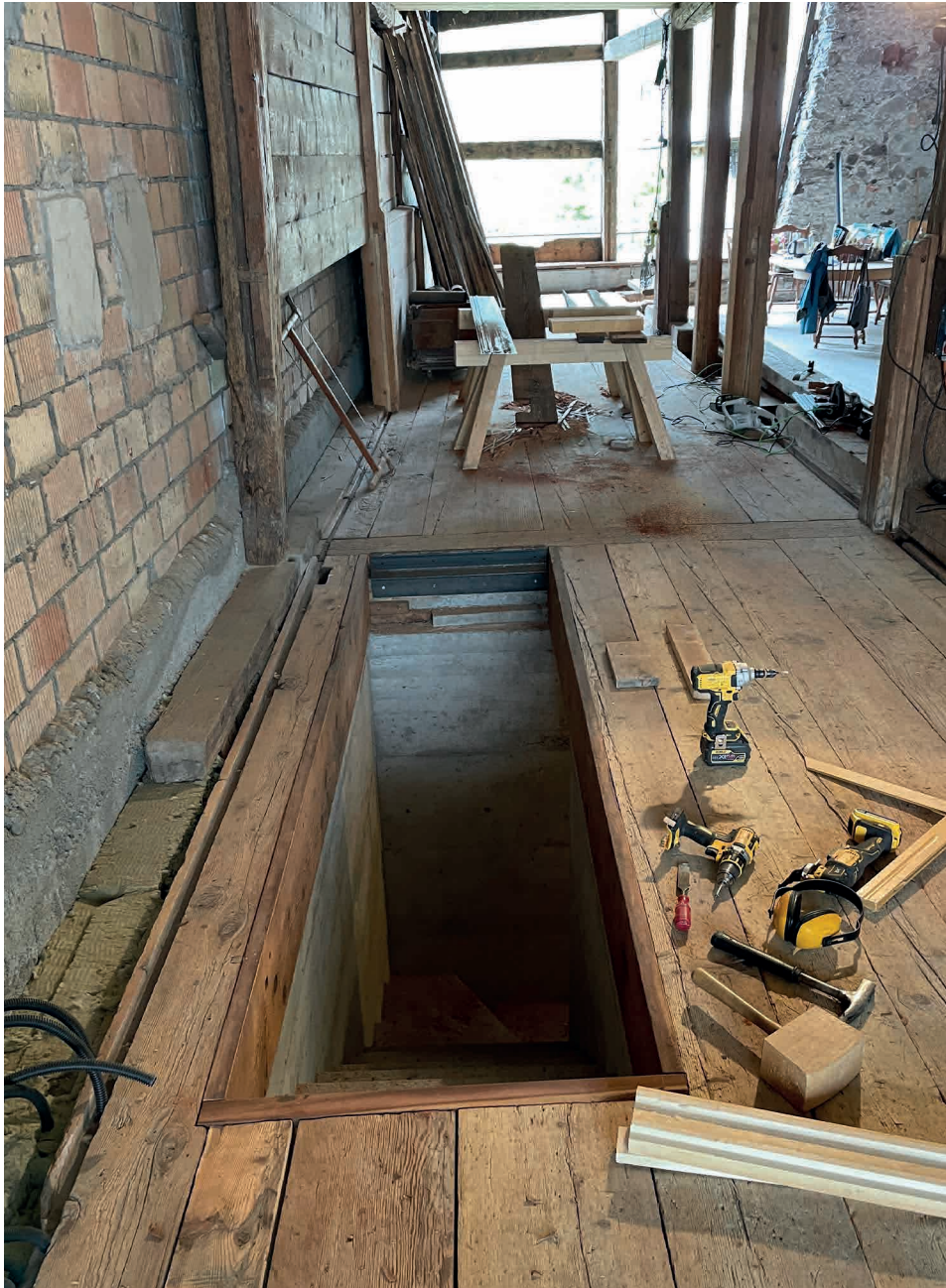
Altholzfutter für die Bodenklappe mit Beschlag
