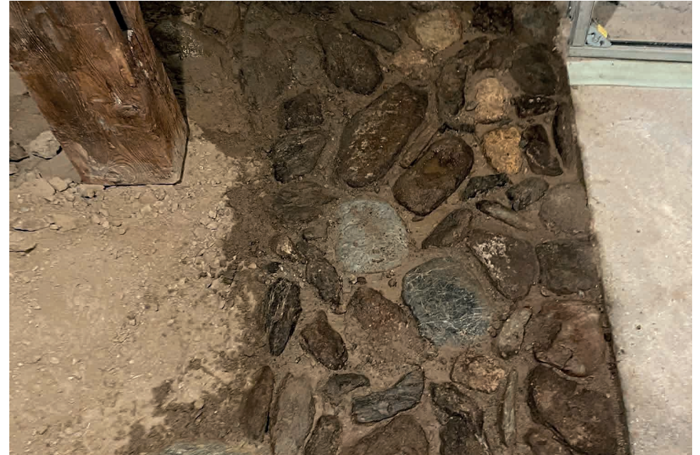
Flusskieselsteinboden im Stall 21.08.2022
