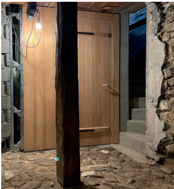
Das Bau-WC bekommt eine Türe 07.10.2022
