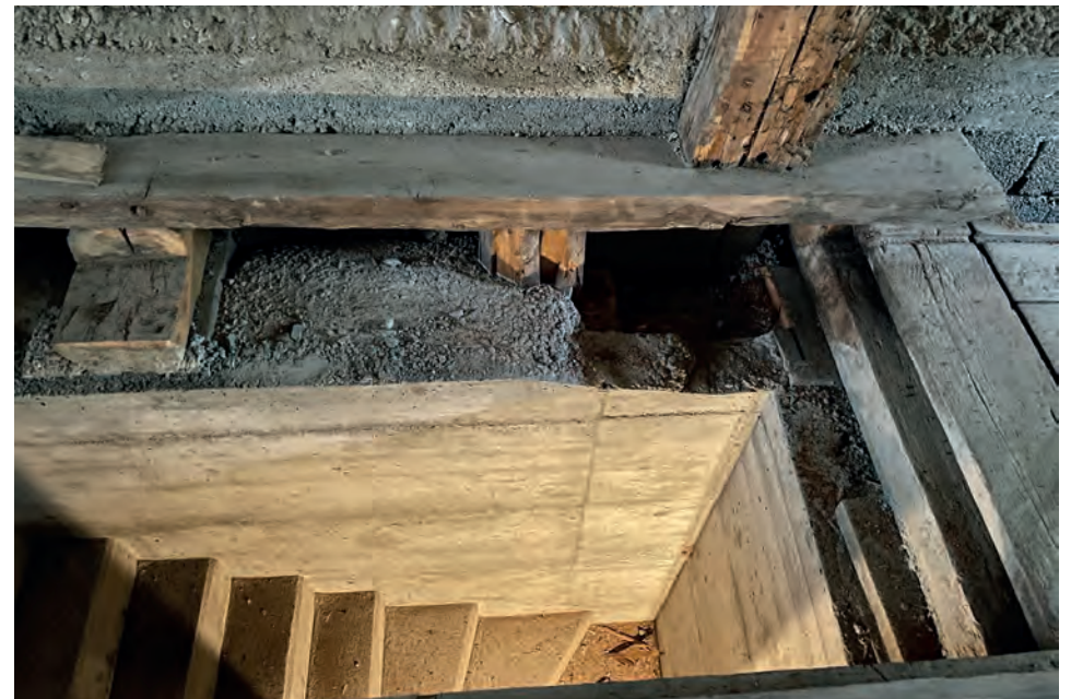
Treppe in den Stall 02.12.2021
