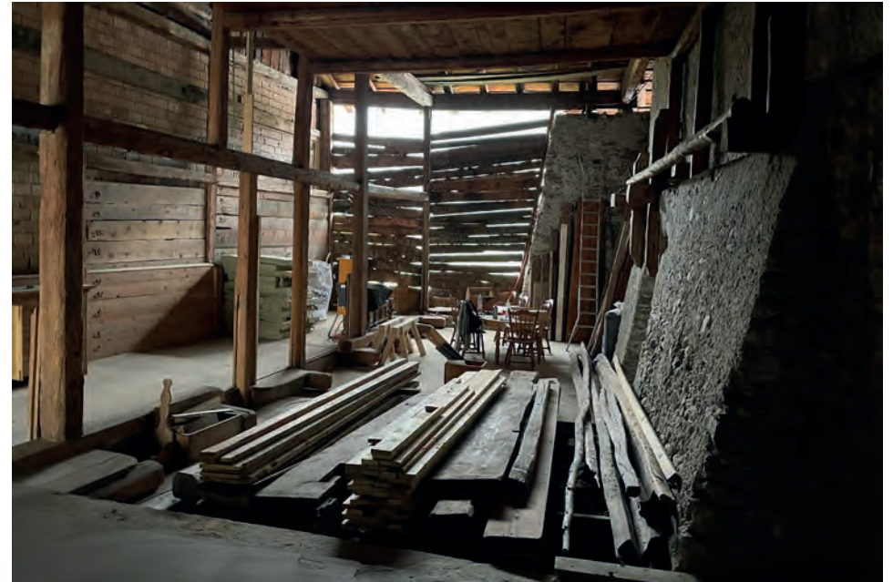
Die Auflagerbalken für die Lange Bühne sind gerichtet 07.10.2022
