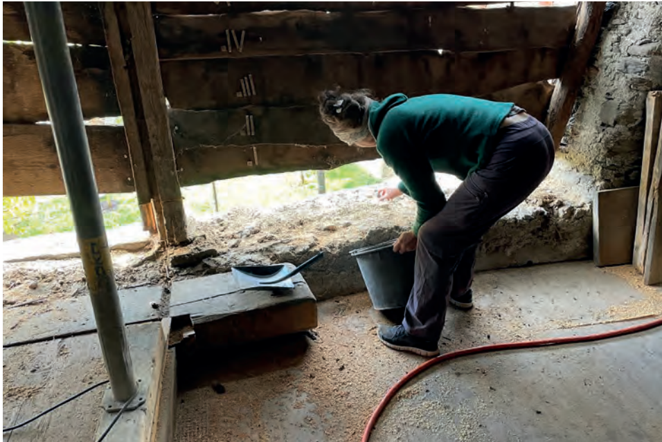
Vorbereitungen für den Betonriegel 22.10.2022
