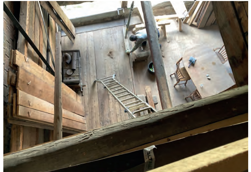
Vorbereitung Metallrahmen Loggia 07.05.2023
