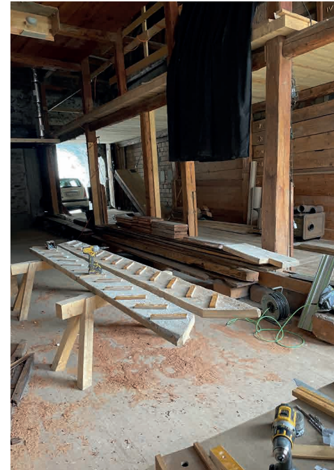
Prov. Treppe in Arbeit
