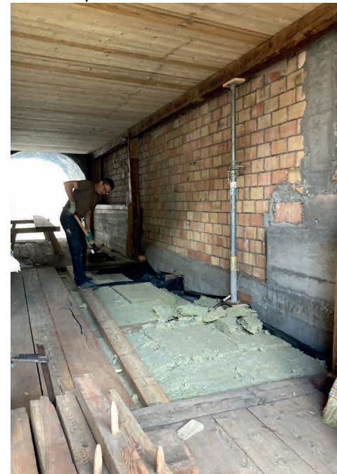
Dämmung Boden EG 28.05.2023
