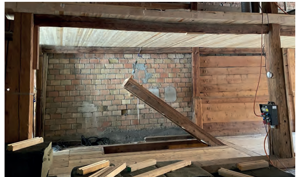
Befahrbare Bodenklappe aus jahrhunderte alten Lärchenbohlen
