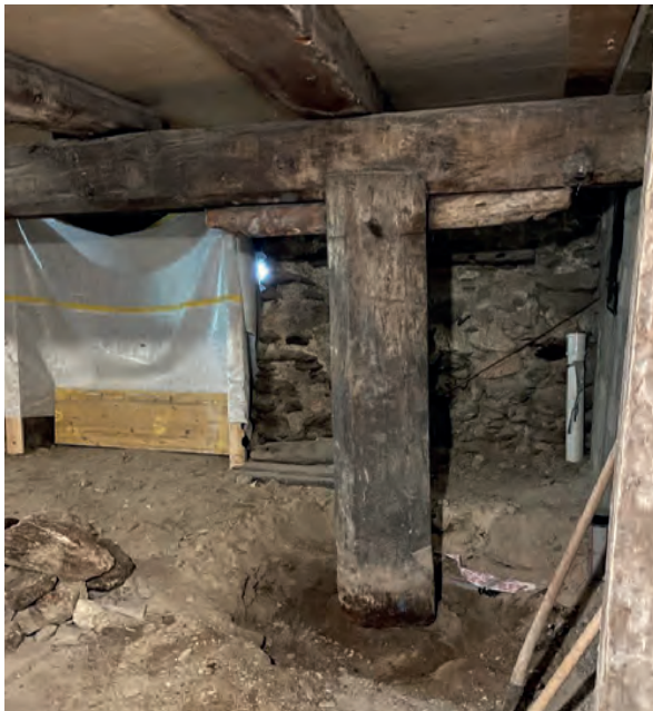
Die Stütze wird trocken gelegt 22.06.2022
