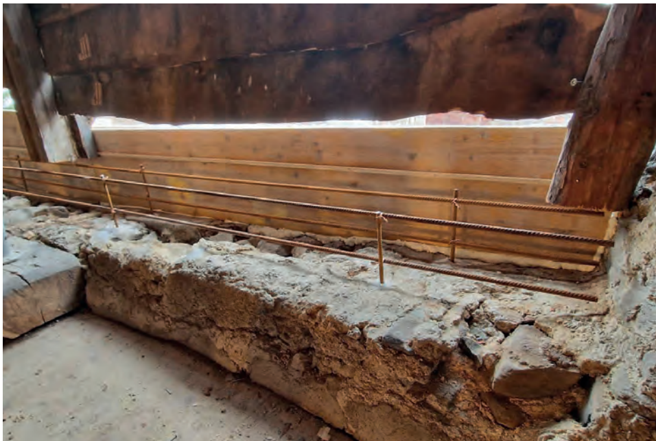
Vorbereitet für den Betonriegel 22.12.2022
