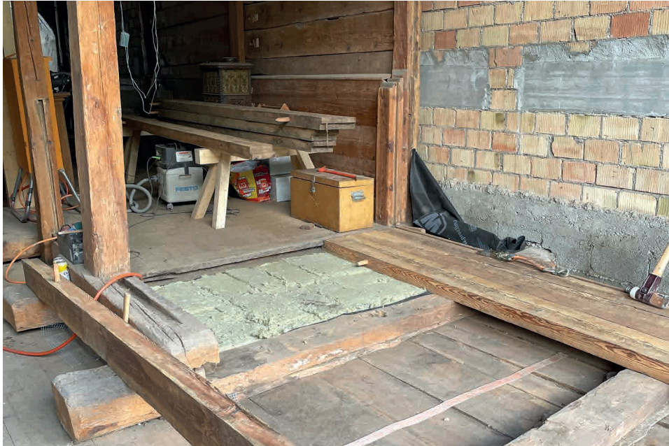
Das erste Bodenfeld wird isoliert 15.08.2022
