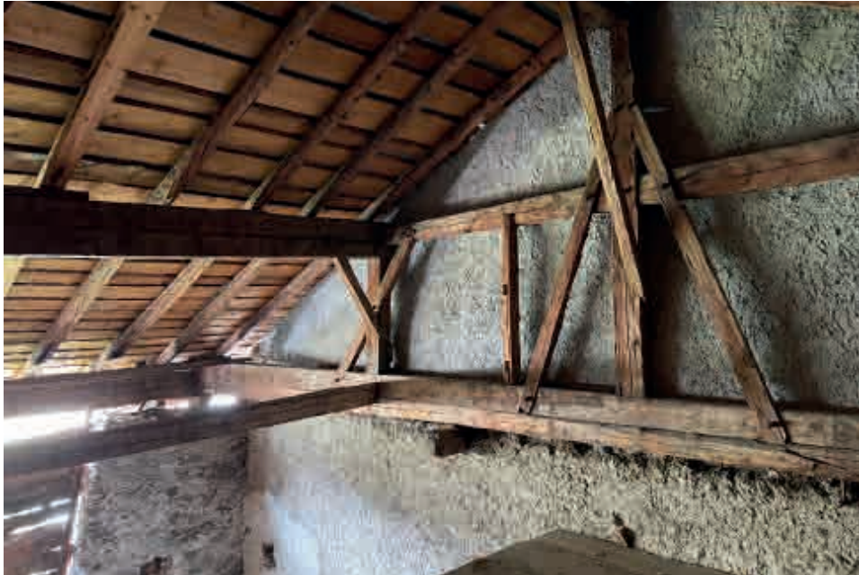
Ansicht Dachstuhl auf Höhe Studio 05.03.2022
