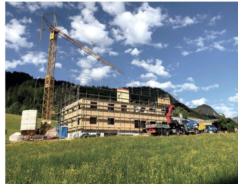
Dank der hohen Vorfertigung der Holzelemente ging der Bau des Apartmenthauses sehr rasch. Das Decken- und Wandsystem des basiert auf einer Mischung aus Skelettkonstruktion an der Südseite und Holzrahmenbau.
